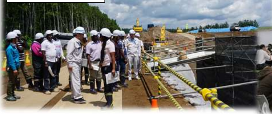
明渠排水路工事現場視察
