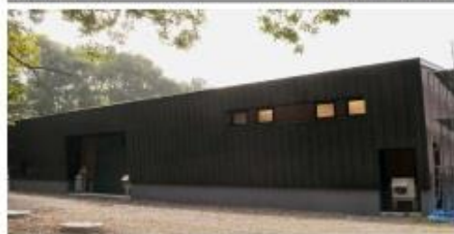
完成間近の「めむろワイナリー」の施設
