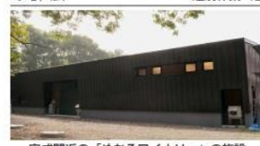
完成間近の「めむろワイナリー」の施設
